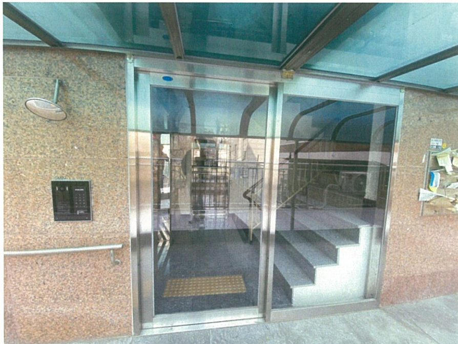
본건 소재 건물 공동출입구
