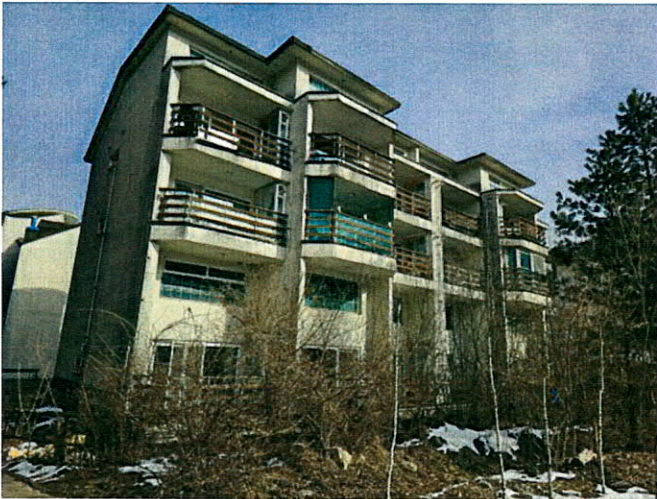
일련번호(1) 건물 정면 전경
