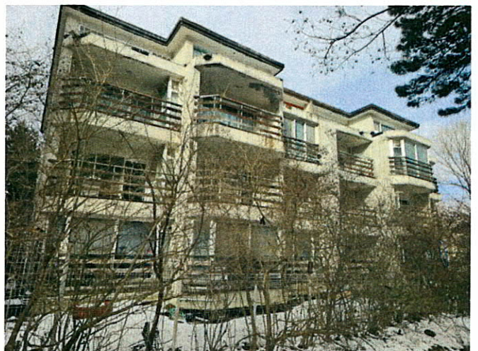
일련번호(2) 건물 정면 전경
