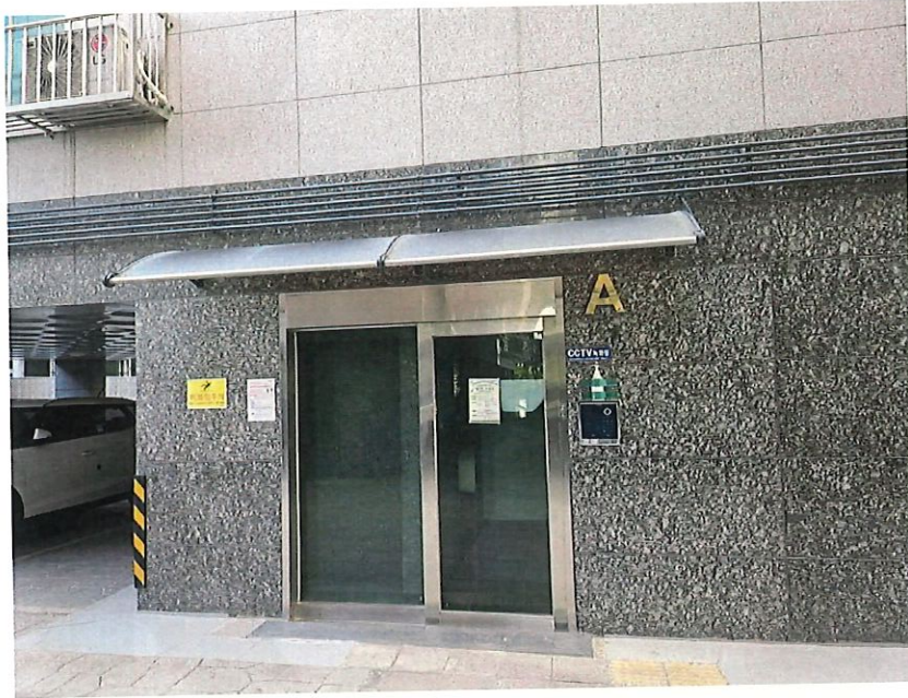
본건 1층 출입구
