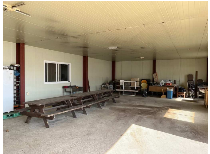
기호(5) 1층 창고 내부
