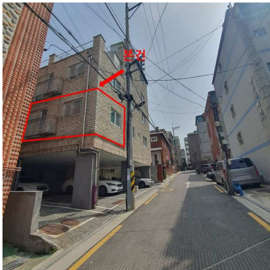
본건 서측 인접도로 주위환경(북측 -> 남측)
