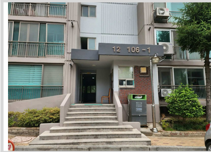
1층 출입구 전경
