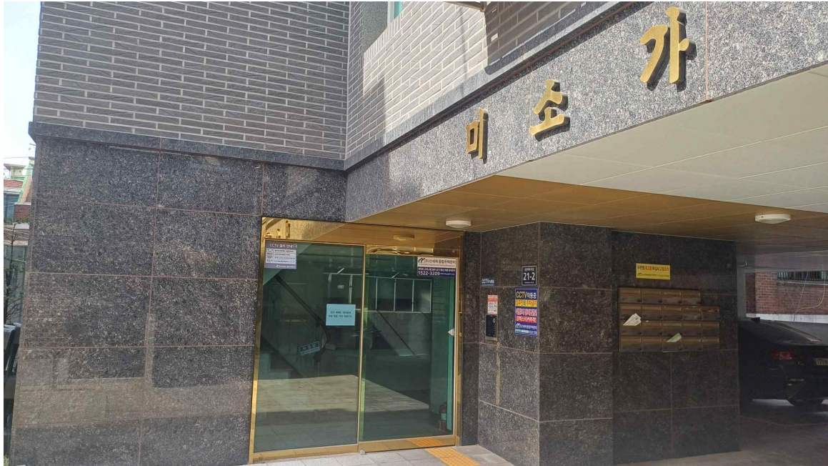
[본건 건물 공동출입구]
