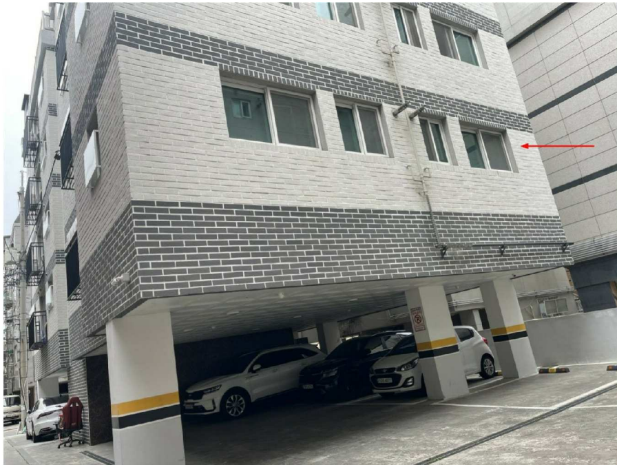
본건 북측 전경
