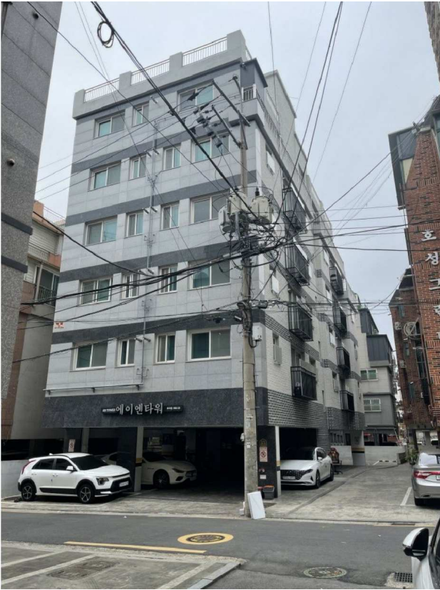
본건 소재 건물 남동측 전경
