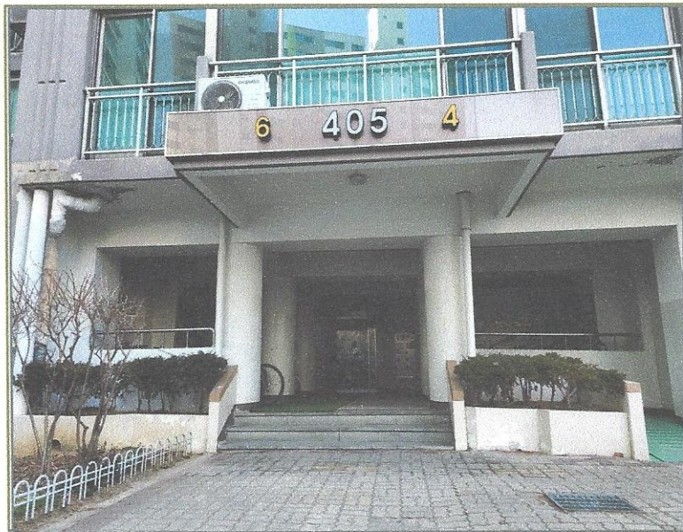
1층 출입구 전경
