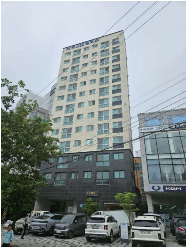
대상물건 소재 건물
