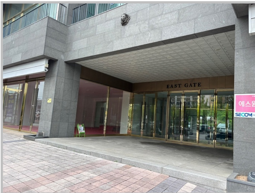
【 본건 주출입구 전경 】
