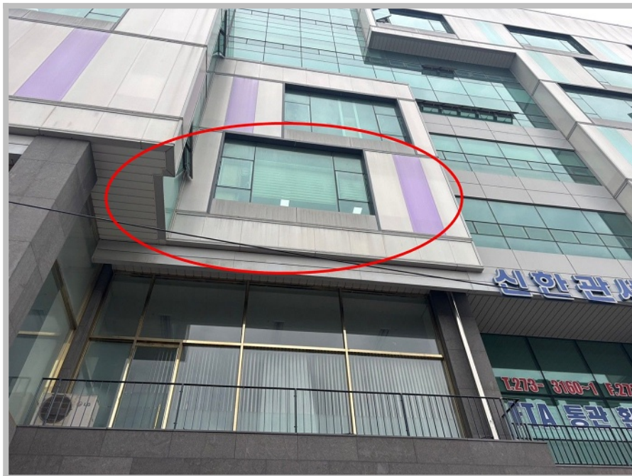
【 본건 외부 전경 】
