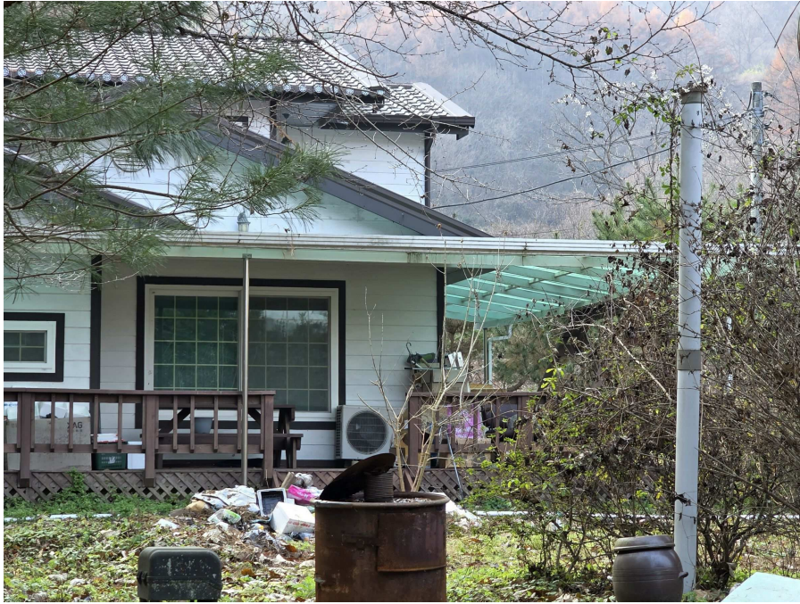
제시외 건물 ㄴ) 전경
