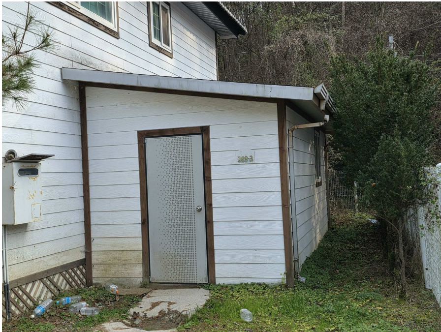
제시외 건물 ㄱ) 전경
