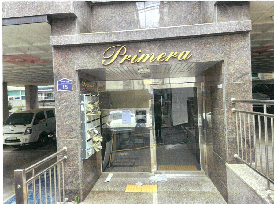
【 본건 전체 건물 출입구 】
