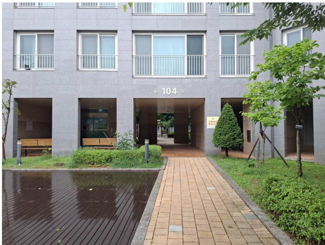
본건 공동 출입구
