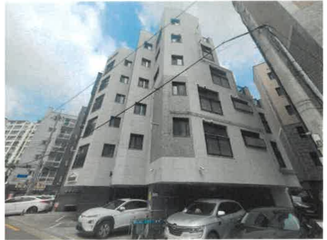
본건 건물 소재 측면
