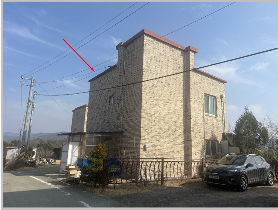
【 본건 기호(1~3) 북서측 전경 및 제시외건물 ㉠ 】
