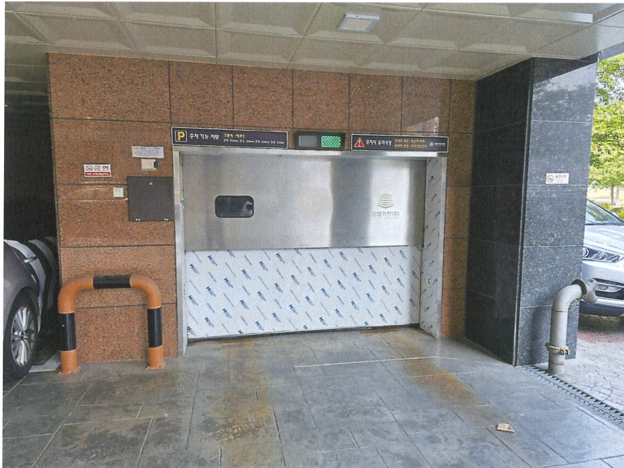
본건동 기계식 주차장 출입구 전경
