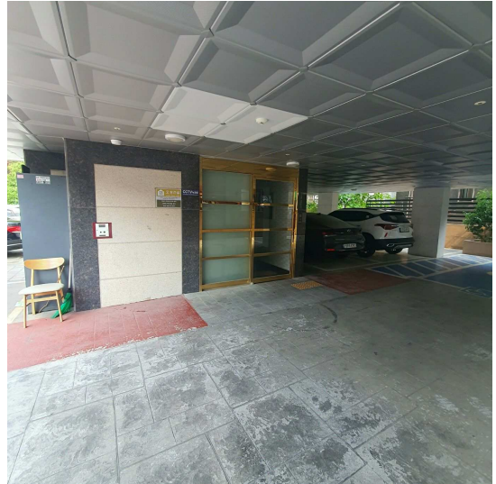
1층 공동 출입구
