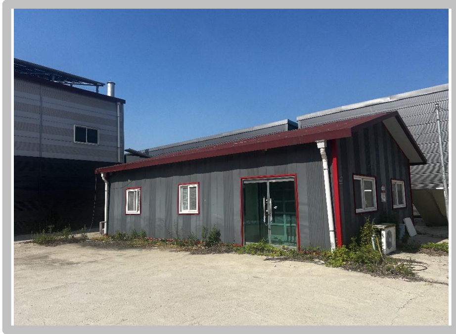
【 건물 기호 (4) 전경 】
