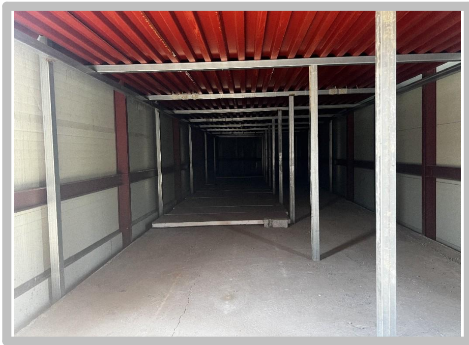
【 건물 기호(7,8) 내부 전경(3층) 】
