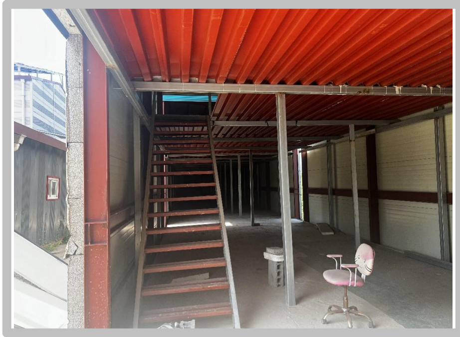
【 건물 기호(7,8) 내부 전경(2층) 】
