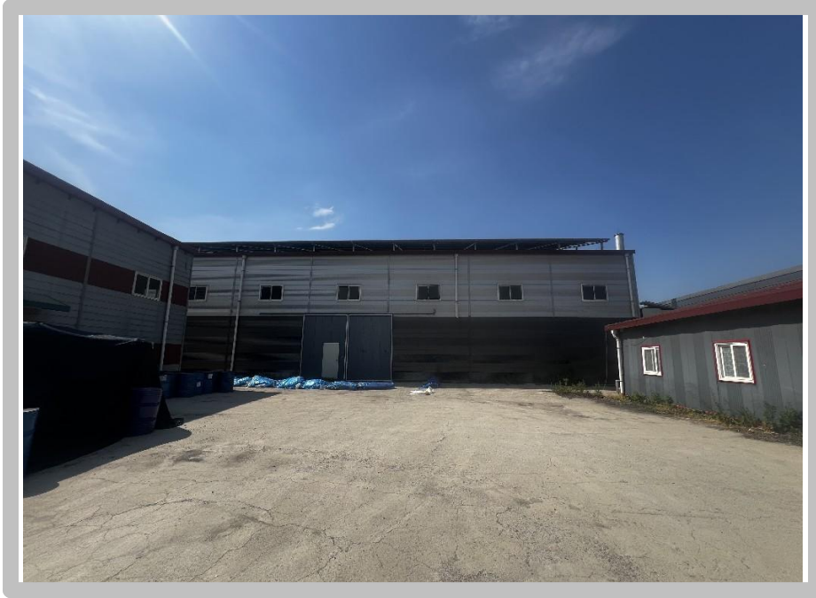
【 건물 기호 (5) 전경 】
