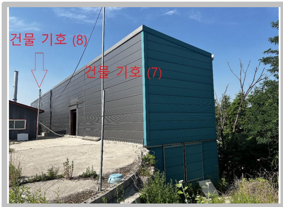
【 건물 기호 (7,8) 전경 】
