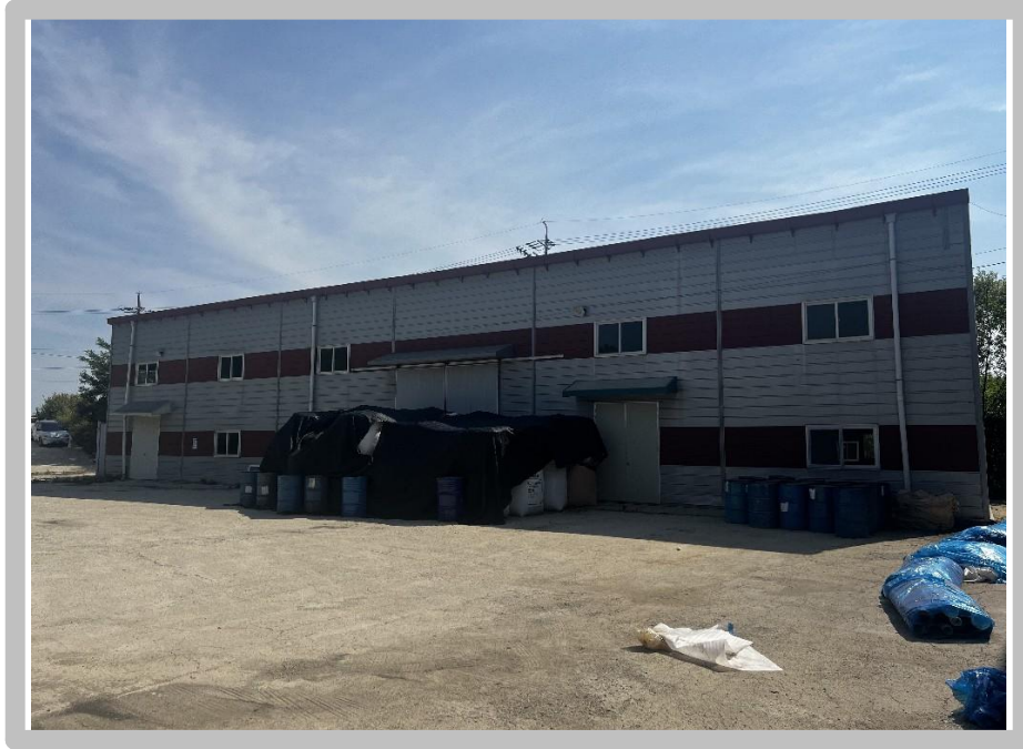
【 건물 기호 (6) 전경 】
