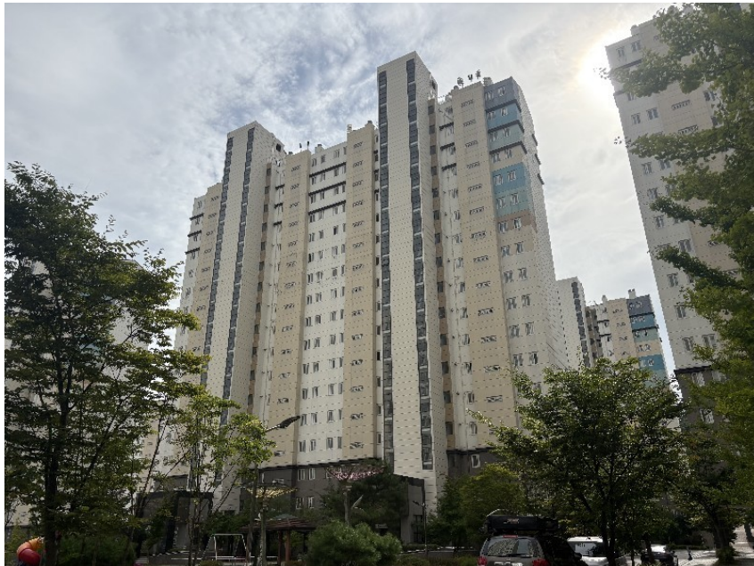
【본건 건물(106동) 전경】
