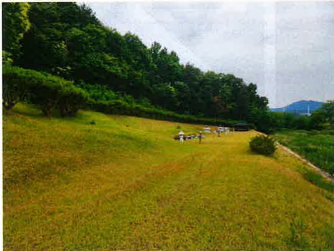
본건 일련번호 1, 2) 전경 (남측에서 촬영)
