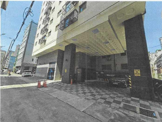
1층 현관 및 주차장
