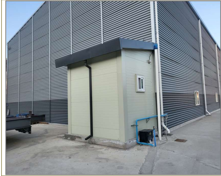
본건2) 화장실 전경
