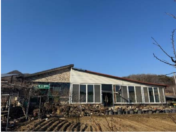
【일련번호 1 및 제시외 건물 ㄱ】
