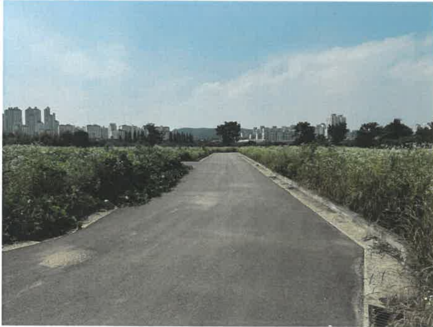
본건 기호(2) 토지 현황 도로
