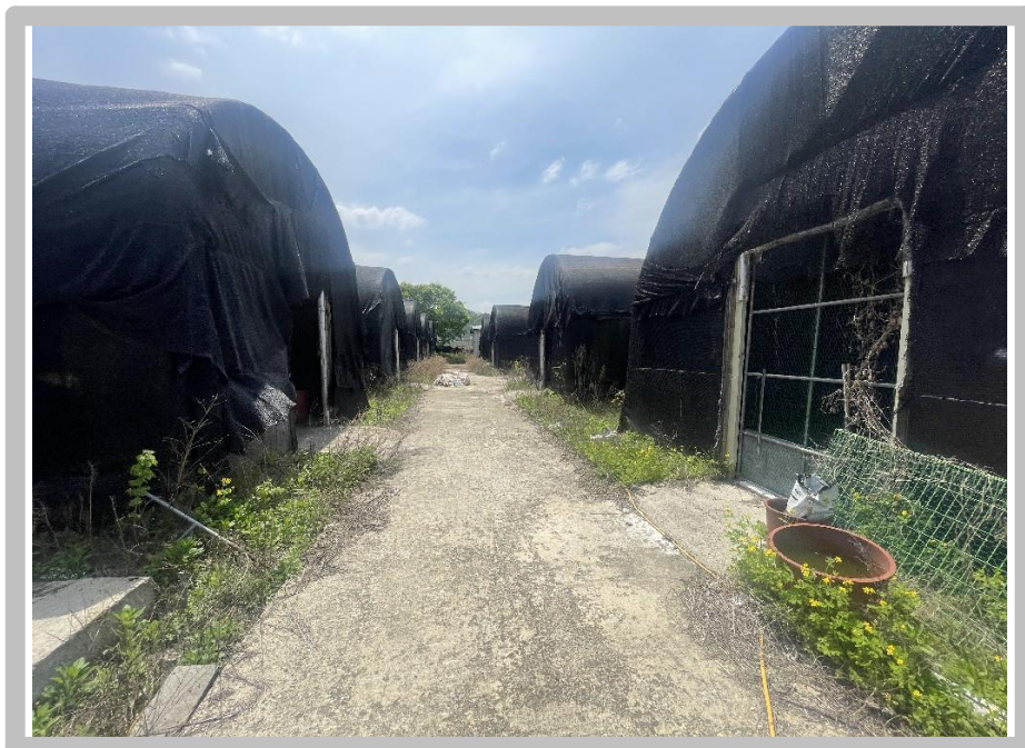
【 본건 기호(1, 2) 제시외건물(1~13) 전경 】
