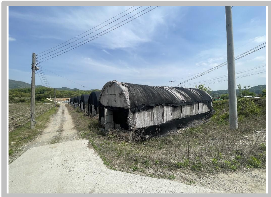
【 본건 기호(15) 제시외건물(49~59) 전경 】
