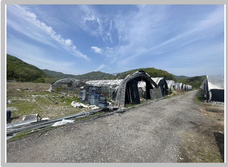
【 본건 기호(13) 제시외건물(24~36) 전경 】
