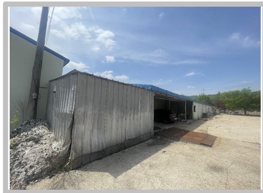
【 본건 기호(3, 4, 17) 제시외건물(15) 전경 】
