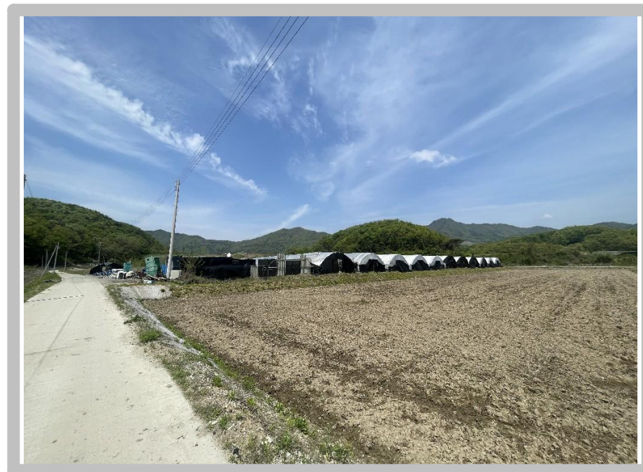
【 본건 기호(14) 제시외건물(38~48) 전경 】
