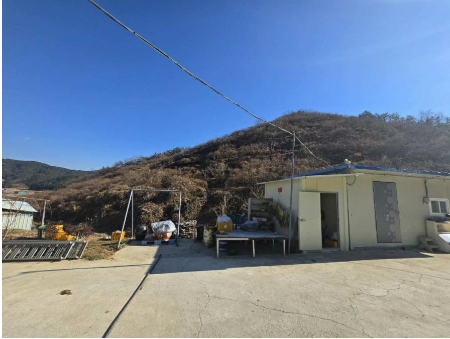
기호(1~4) 전경, 북서측 인근 촬영
