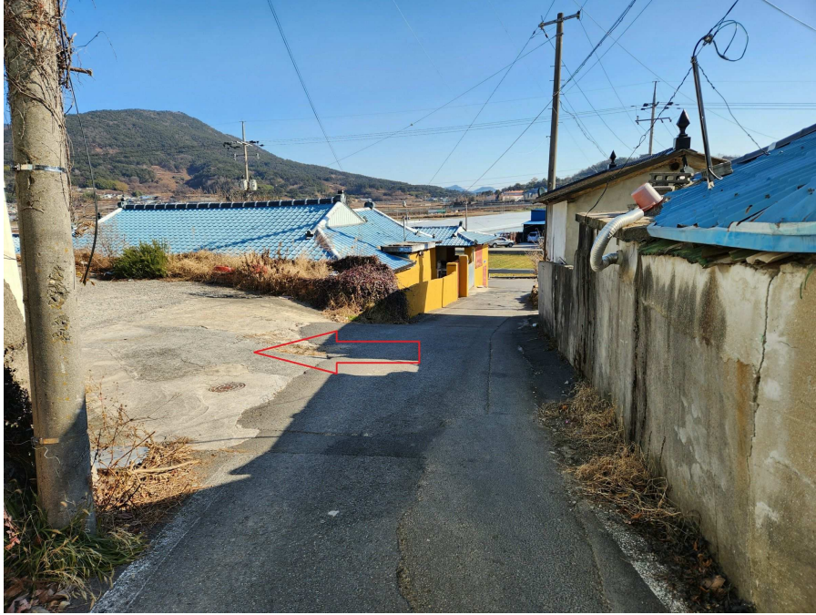
남측으로 접면한 도로 등 도로 서측에서 동측을 향하여 촬영
