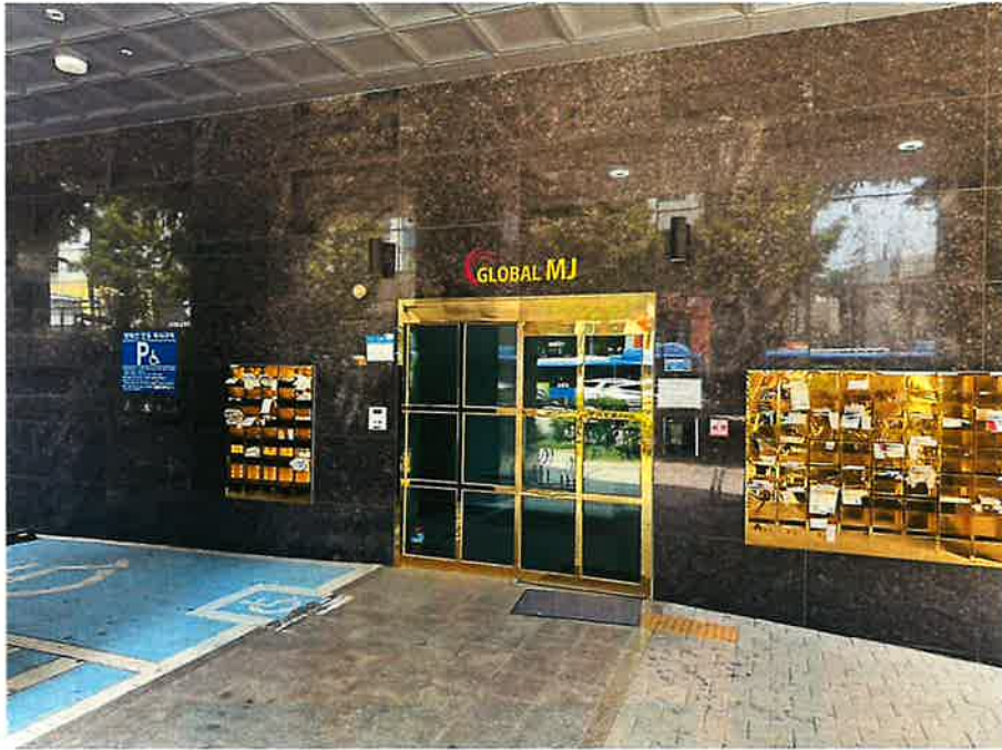
공동 현관 전경
