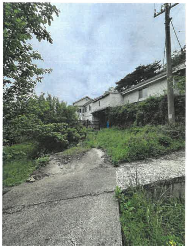
건물 (3-2) 외부 전경 - 1
