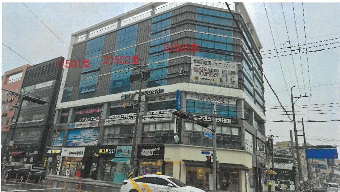
본건 외부 전경
