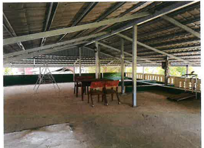
일련번호 3) 건물 옥상 전경
