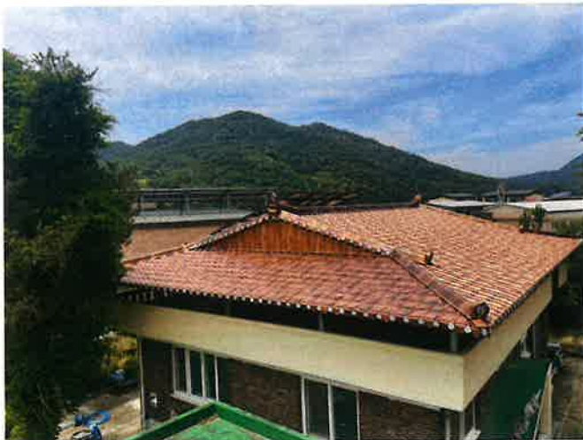
일련번호 3) 건물 지붕 전경
