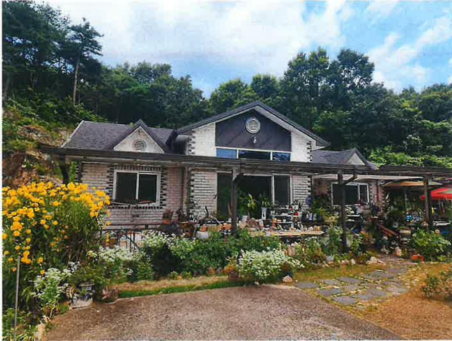
일련번호 2) 및 제시외 건물
