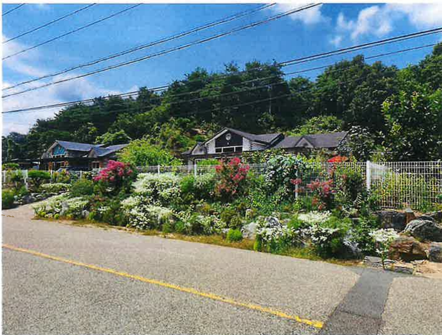
본건 전경 (남동측에서 촬영)
