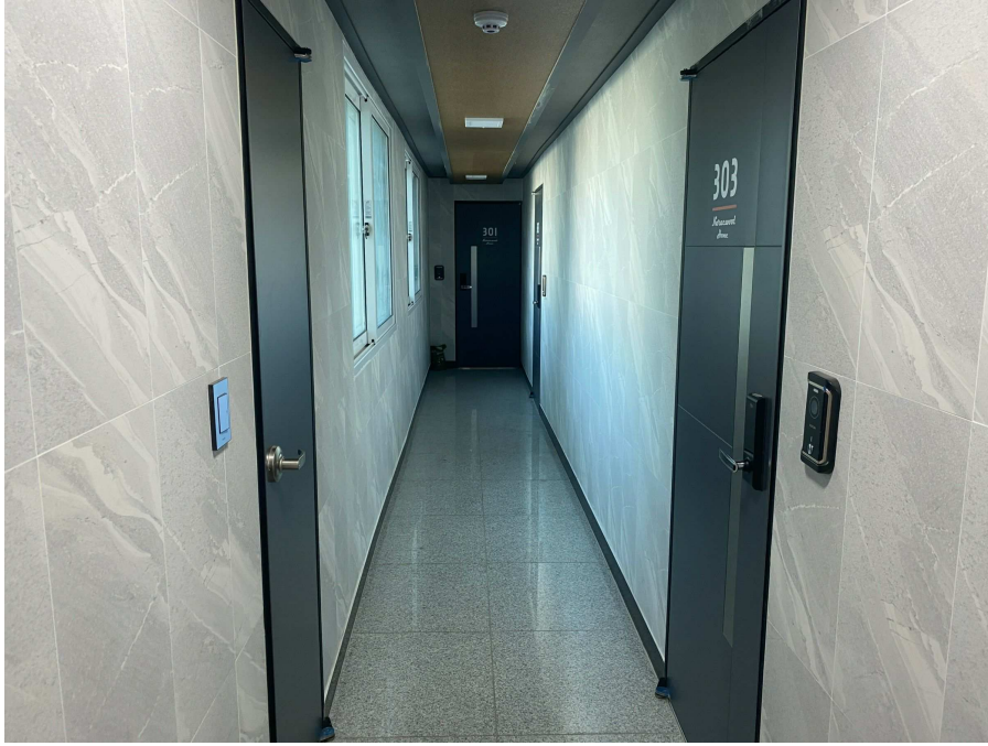
본건 건물 3층
