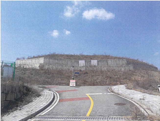
본건 단지 남동측 내부 촬영
