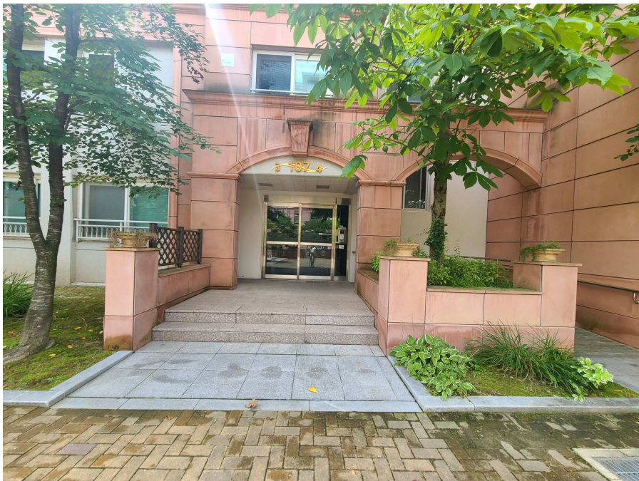
본건 제107동 3,4호라인 출입구 전경
