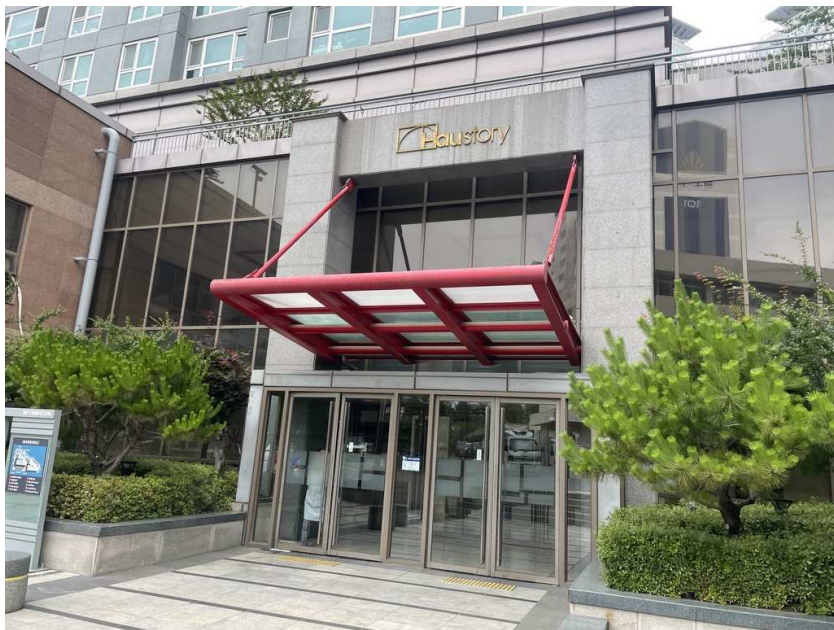
본건 공동 출입구
