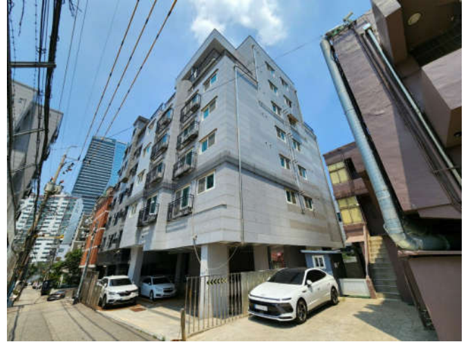
대상물건 소재 건물
