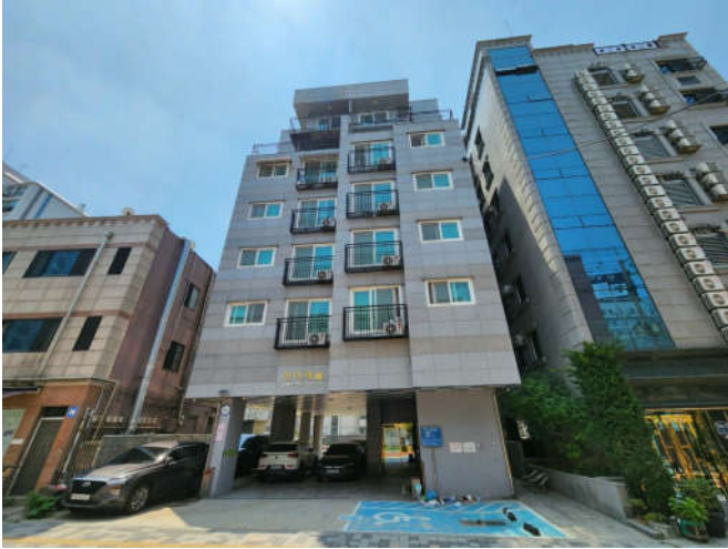
대상물건 소재 건물
