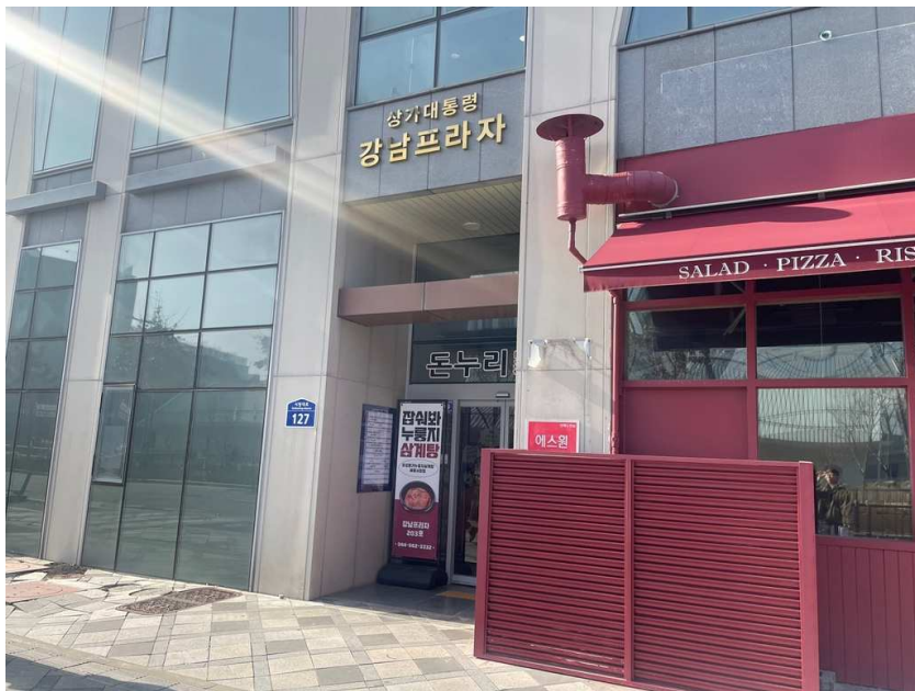
대상물건 1층 주출입구 전경
