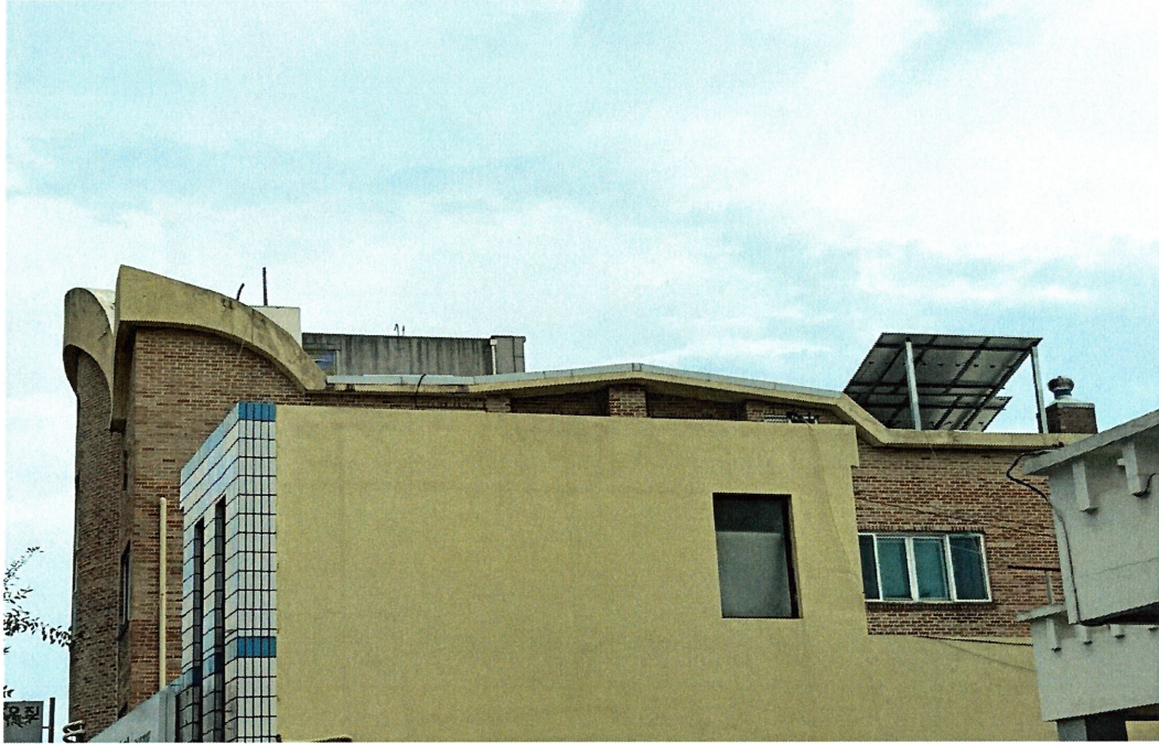
【 대상물건 일련번호(2) 누다락 및 물탱크실 부분 】
