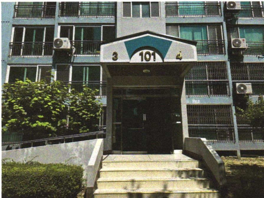
대상물건 일련번호1 공동출입구 전경
