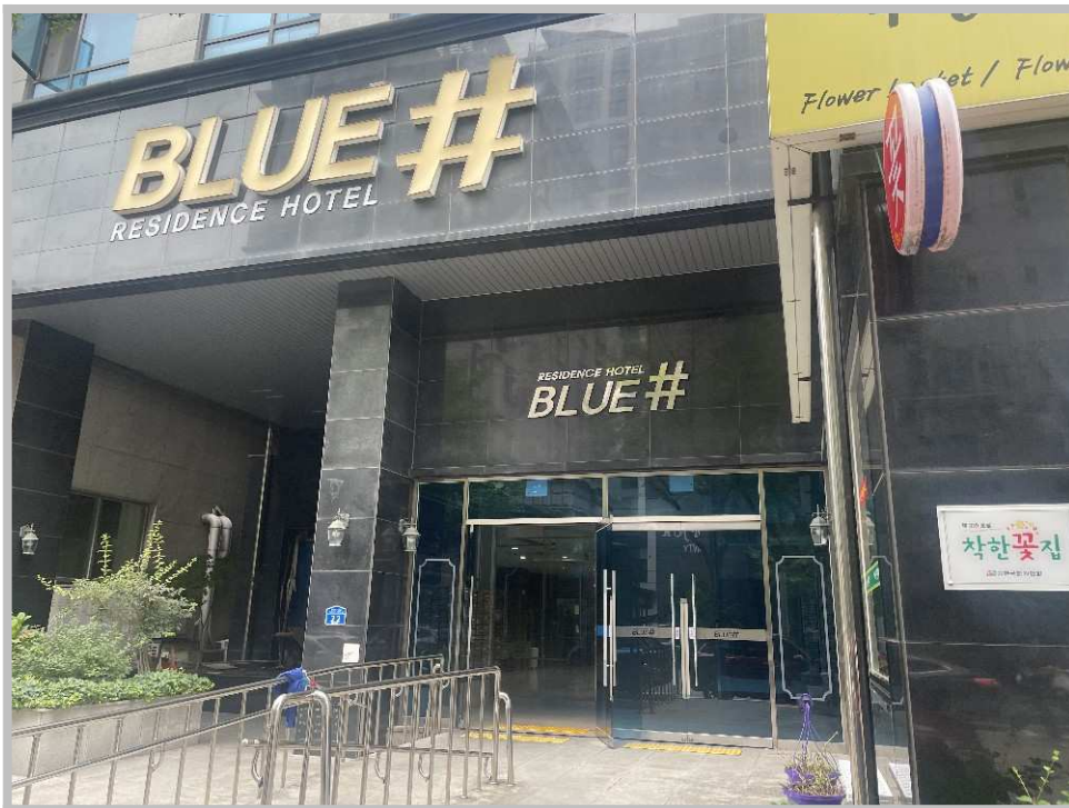
[대상물건 1층 주출입구 전경]
