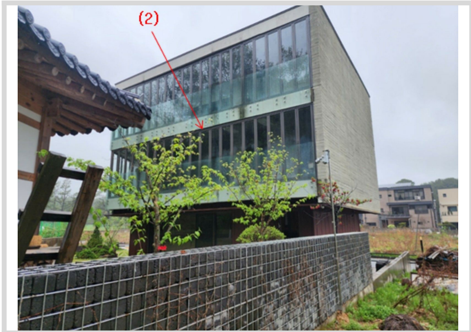
기호(2) 전경 - 본건 남동측에서 촬영
