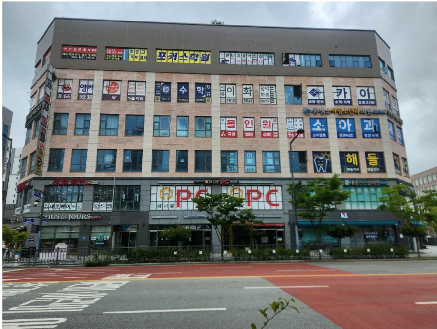
대상물건 소재 건물 전경(북동측에서 촬영)
