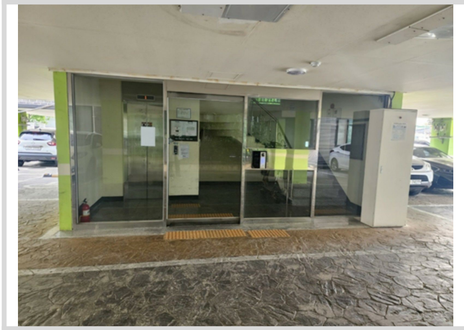
본건 1층 소재 공동 출입문 전경
