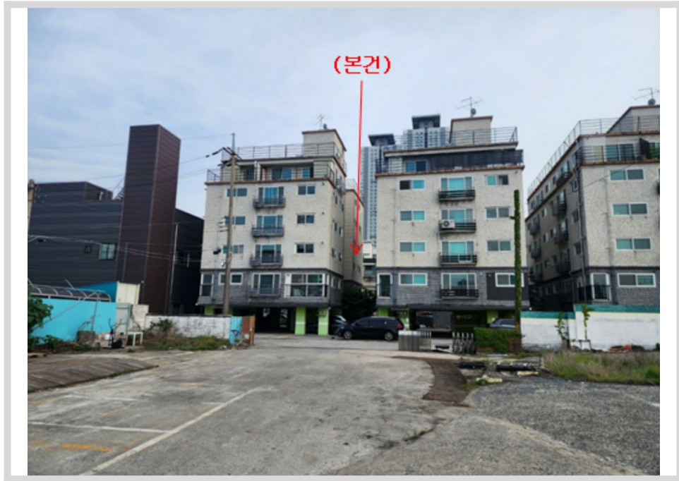
본건 주변 전경 - 본건 북서측 인근에서 촬영
