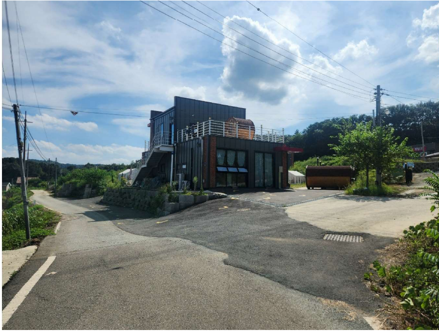
대상물건 전경(북동측에서 촬영)
