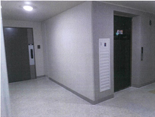
본건 6층 복도 및 E/L 촬영
