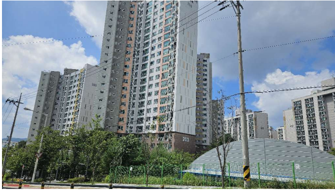
일련번호(1) 삼정그린코아포레스트(2단지 ) 203동 전경
