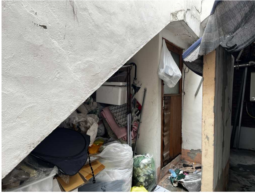
본건 부속건물 전경
