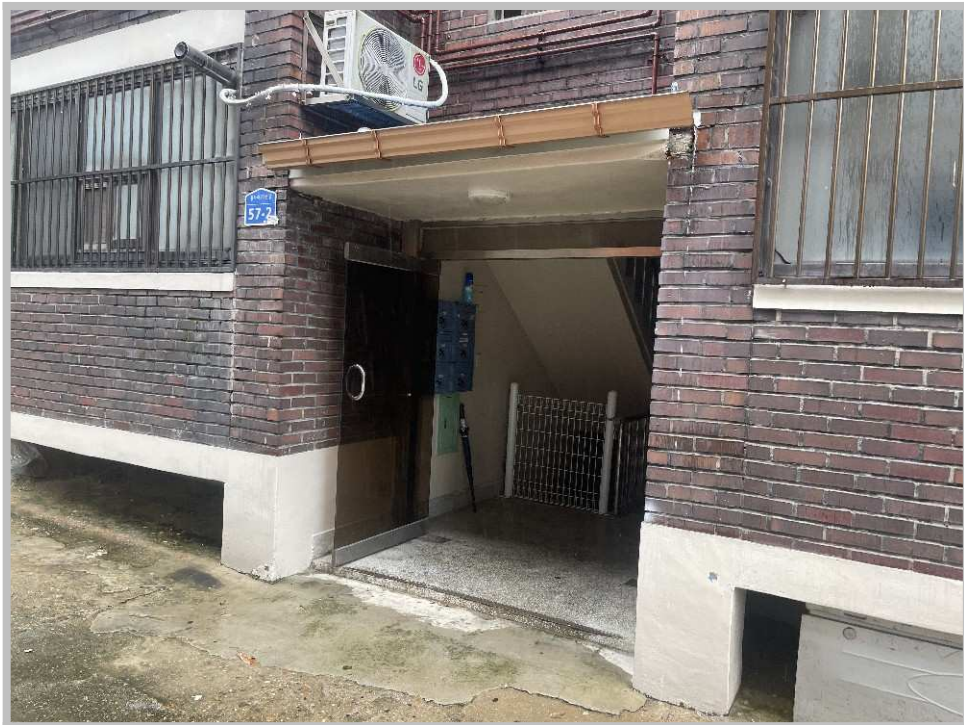
[대상물건 1층 주출입구 전경]
